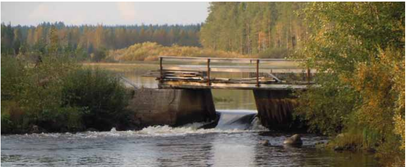
Kuva 6. Hirvaskosken voimalaitoksen säännöstelypato.
