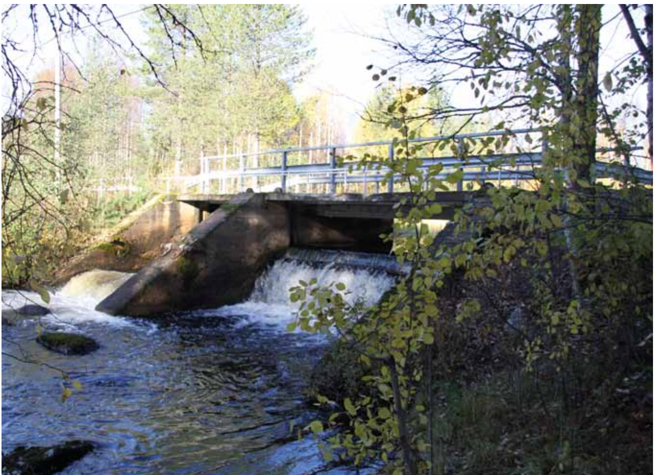
Kuva 13. Puhosjärven uittopato ja paikallistien silta, joiden yhteyteen on tehty pikkukalojen nousueste.
