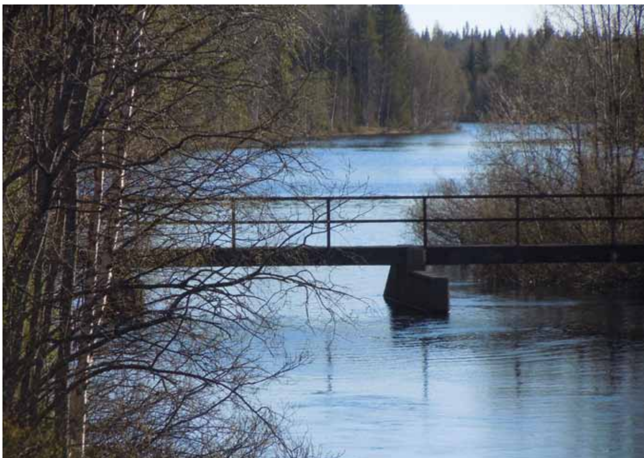
Kuva 10. Kuusamontien vieressä Kalliojärven uittopadon jäljellä olevat betonirakenteet.
