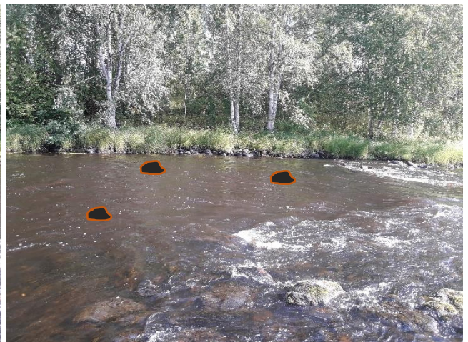
Kuvat 12-13. (kohta 6). Niskalle 60 tonnia kutusoraa/poikaskiveä. Lisäksi muutama isompi pintakivi hidastamaan ja monipuolistamaan virtausta sekä tuomaan suojapaikkoja.
