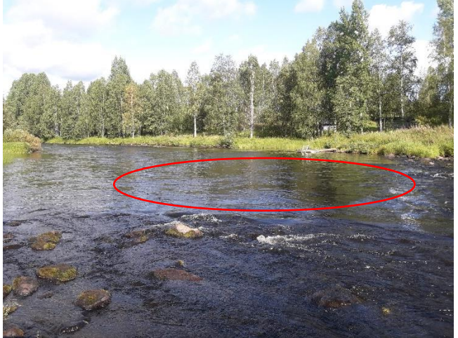
Kuvat 14-15. (kohta 7). 40 tonnia kutusoraa kynnyksen yläpuolelle saaren yläosan kohdalle. Muutama isompi pintakivi myös kovimpaan virtaan ohjaamaan ja monipuolistamaan virtausta sekä jatkamaan kynnystä läpi uoman. Lisäksi paikan kivien levitys laajemman poikaselinympäristön muodostamiseksi.
