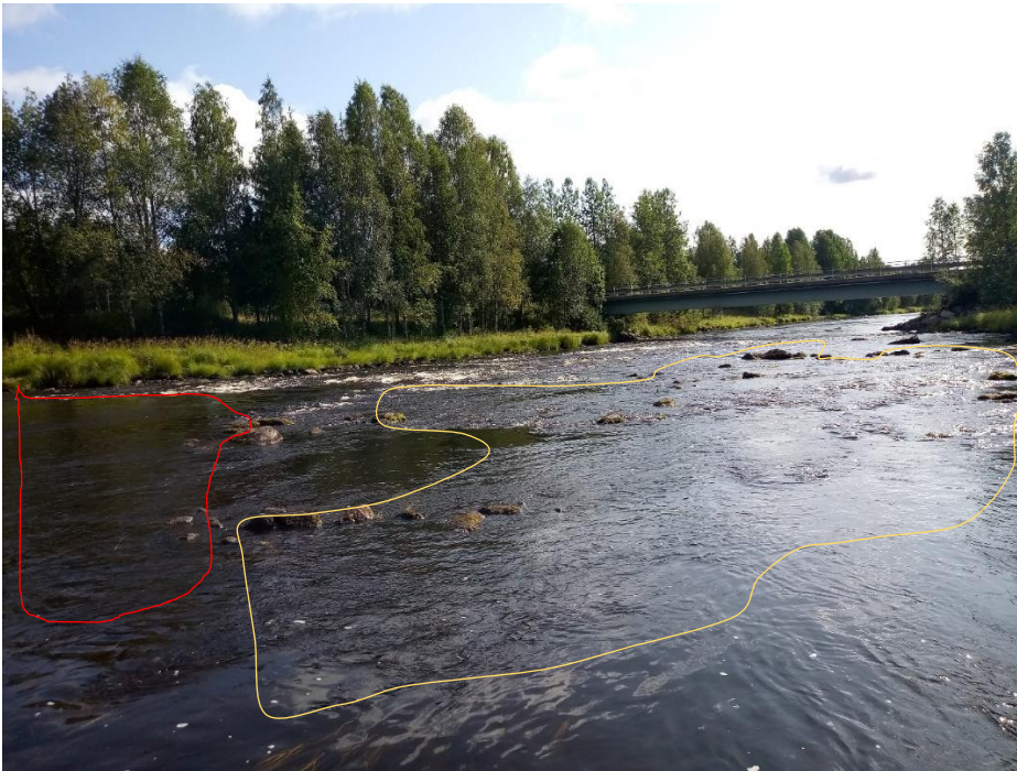
Kuva 9. Kohta 3. Kutusoraikon lisääminen. Kynnyksen niskalle 120 tonnia kutusoraa/poikaskiveä. Kuvan oikea puoli potentiaalinen poikastuotantoalue, jonka pinta-alaa tulisi laajentaa levittämällä ja lisäämällä kiviä.
