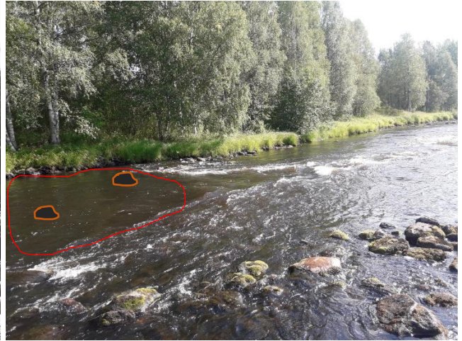
Kuvat 14-15. (kohta 7). 40 tonnia kutusoraa kynnyksen yläpuolelle saaren yläosan kohdalle. Muutama isompi pintakivi myös kovimpaan virtaan ohjaamaan ja monipuolistamaan virtausta sekä jatkamaan kynnystä läpi uoman. Lisäksi paikan kivien levitys laajemman poikaselinympäristön muodostamiseksi.
