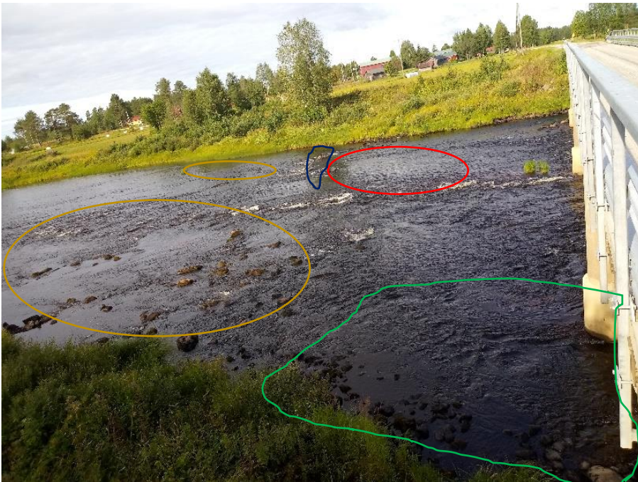
Kuva 41. Kohta 3, 4, 5 ja 6. Kasvi- ja puuaineksen lisääminen (vihreä), kutusoran lisääminen (punainen), betonipalkin poisto ja kynnykseen lisää kiviä (sininen) ja poikasalueen parantaminen ja jatkaminen (ruskea).
