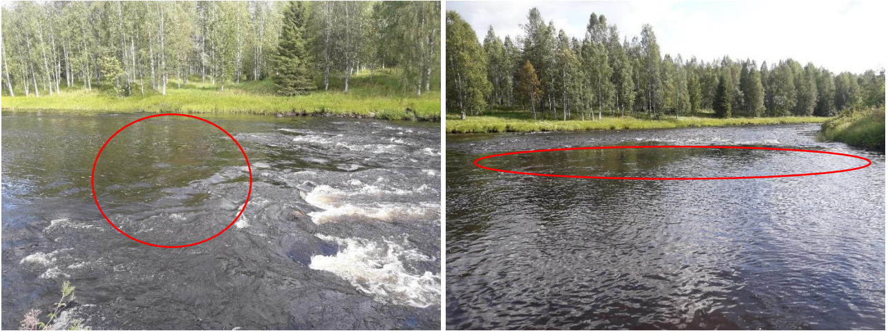
Kuvat 20-21. (Kohta 10). Kutusoraikon/poikaskivikon lisäys. Kynnyksen eteen uoman leveydeltä 100 tonnia.
